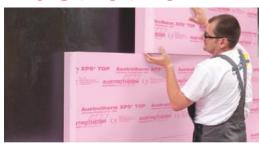
Druckfeste Wärmedämmplatte aus extrudiertem Polystyrolhartschaum mit Stufenfalz (SF)
