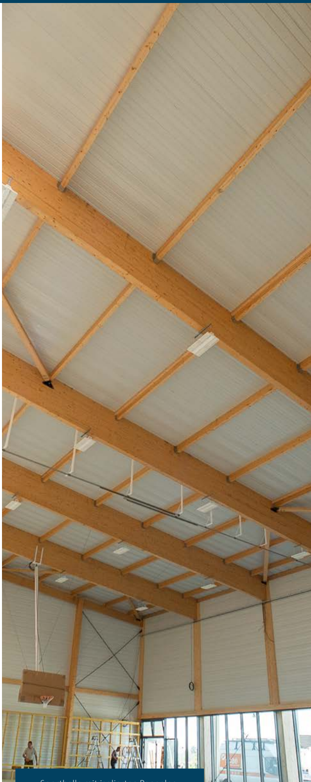
Sporthalle mit isolierten Paneelen.
