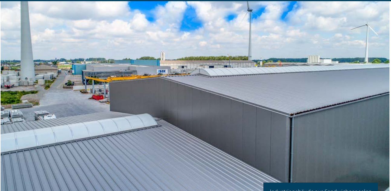
Industriegebäude aus Sandwichpaneelen
