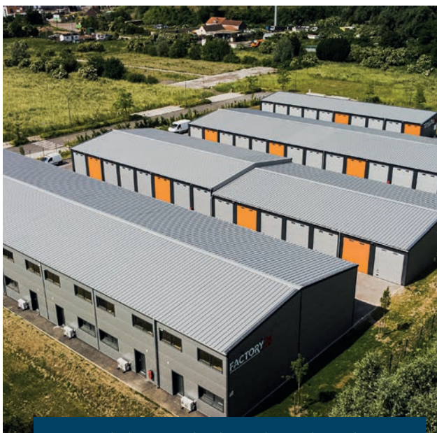
Paneele des Lagergebäudes aus der Vogelperspektive.
