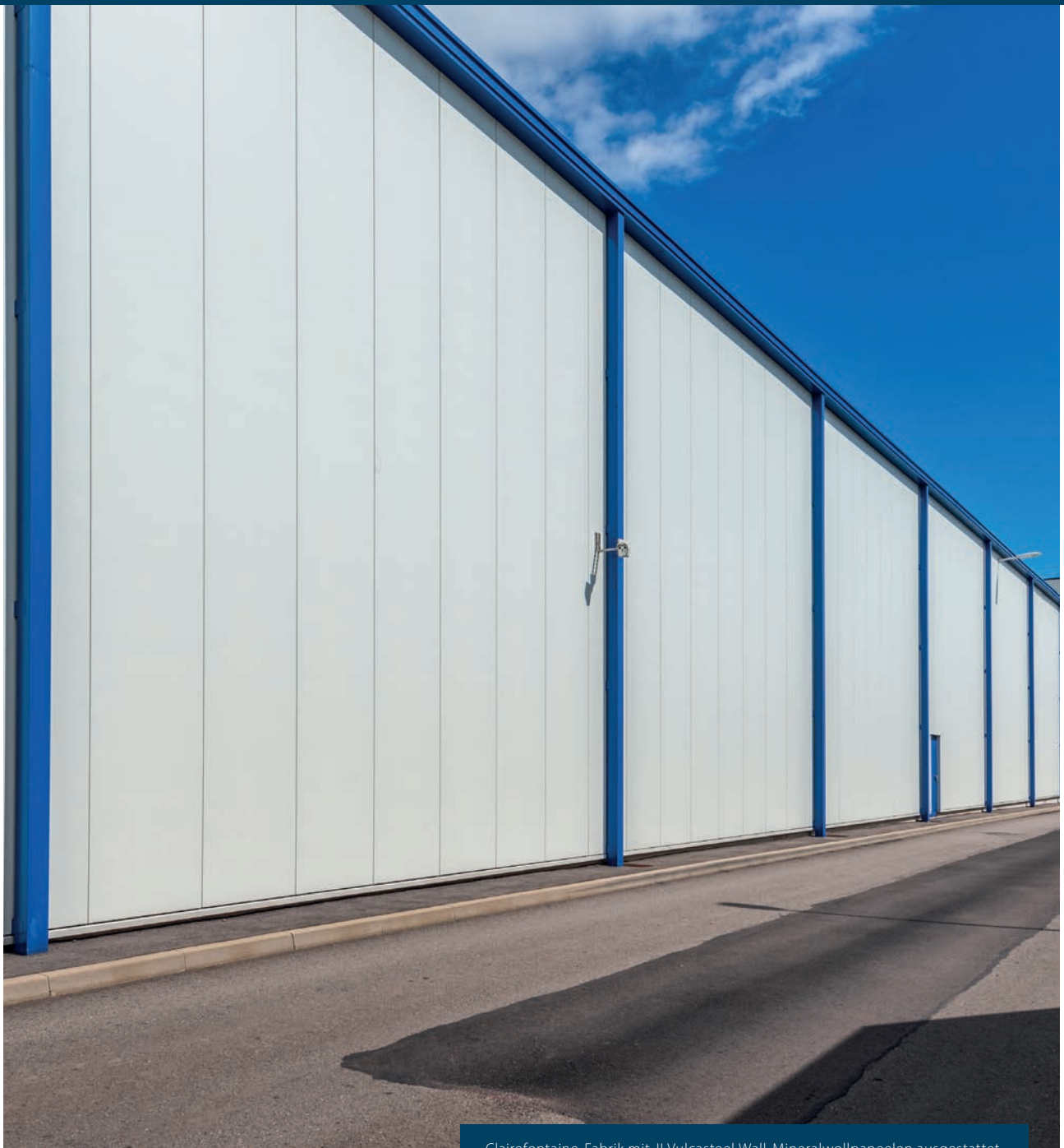
Clairefontaine-Fabrik mit JI Vulcasteel Wall-Mineralwollpaneelen ausgestattet.
