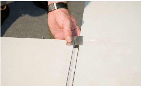
5) Elemente bei Bedarf mit DBE-Verbindungsprofilen fixieren
