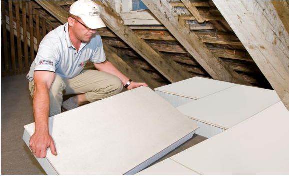
1) Elemente reihenweise im Verband verlegen
