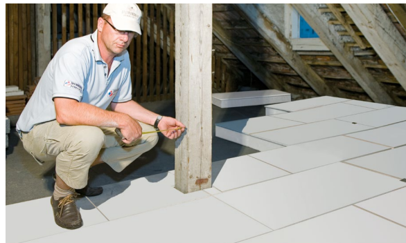
6) Elemente sind sofort nach der Verlegung begehbar
