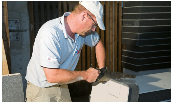
4) Elemente können problemlos mit Stichsäge o.ä. geschnitten werden
