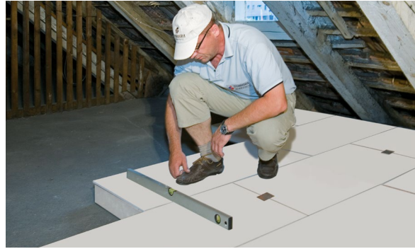
2) Boden auf Unebenheiten prüfen
