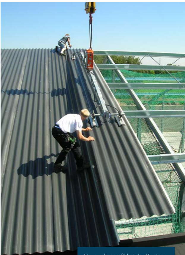
Sinuswellenprofil bei der Montage.
